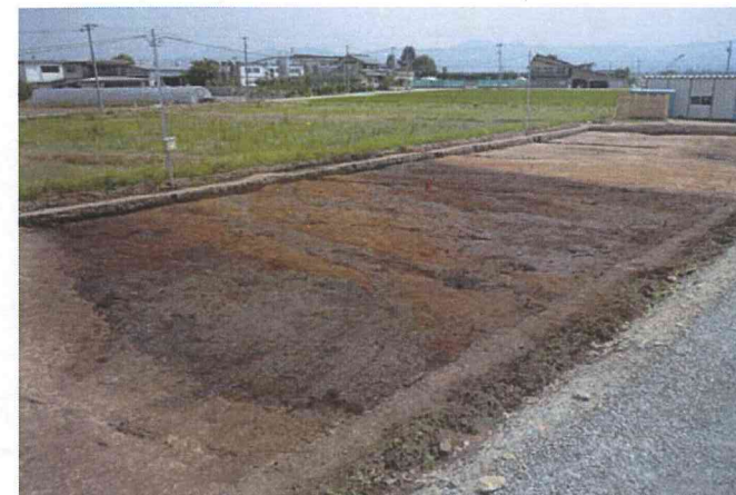
写真4 SG03 河川跡検出状況
